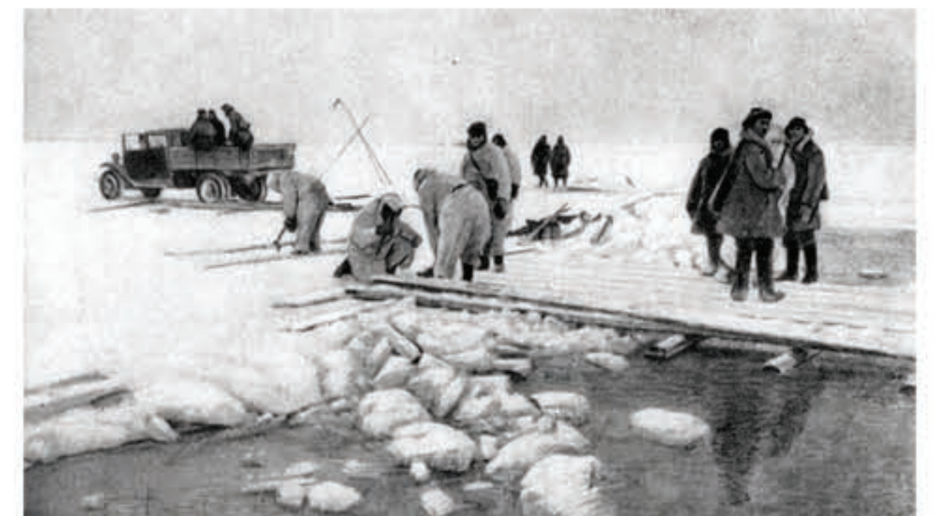
Устройство настилов на участках открытой воды, 1942 Фото: ТАСС
